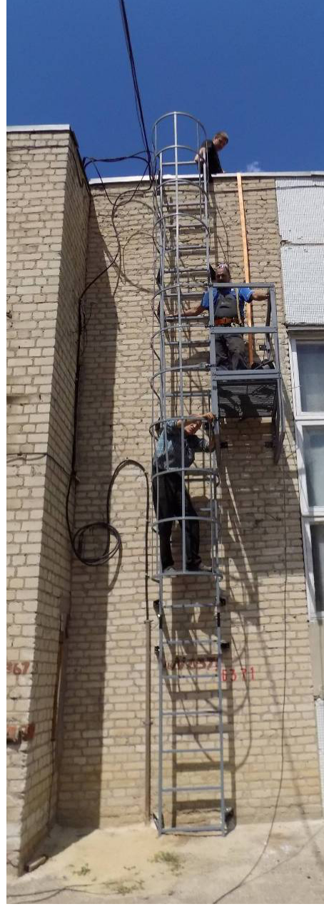
Смонтированная на предприятии заказчика лестница демонстратор (сборка производилась с уровня крыши, т.е. "сверху-вниз")
